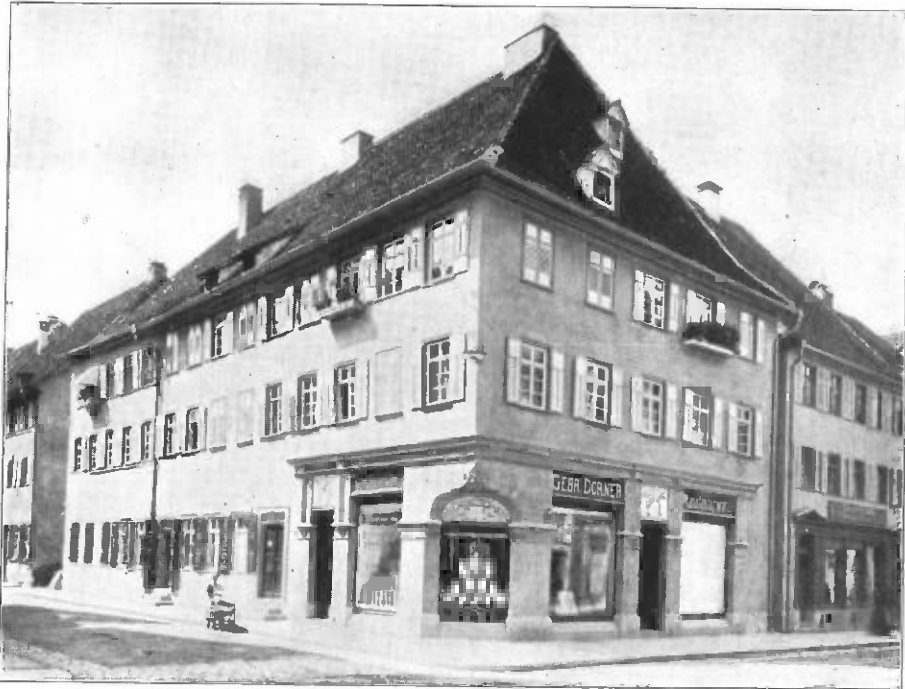
Geschäftshaus Dörner nach seiner Erweiterung; im jetzigen Zustand. (Aufnahme von Adolf Haug.)
