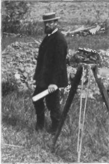
Karl Friedrich August Dörner, Kulturingenieur. * 1861.
